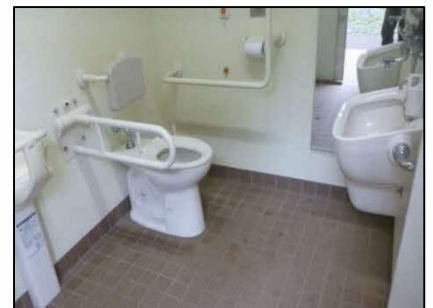
多目的トイレの設置
